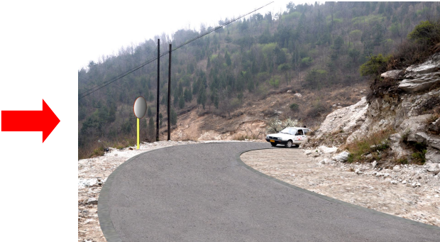
图 4-11-2 视距不良路段处理示例 2(清除弯道内侧遮挡视距的岩体)
