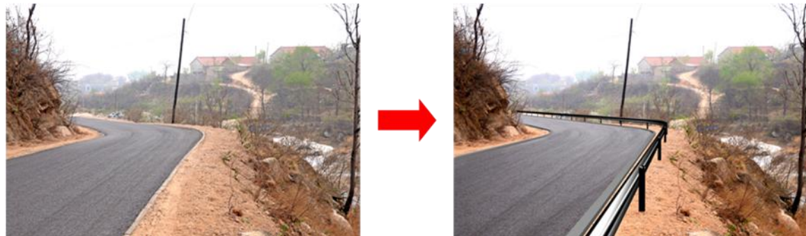
图 4-12-1 路侧险要路段处理示例 1(在险要侧增设波形梁护栏)
