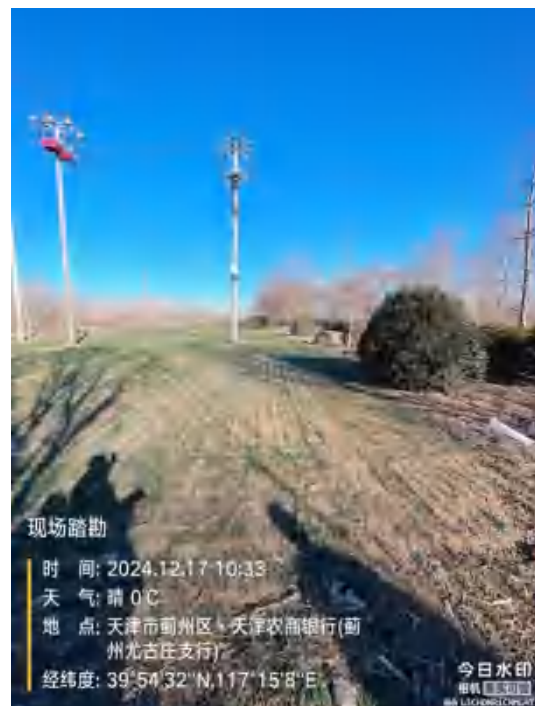
尤古庄镇尤古庄灌溉机井拟建位置
