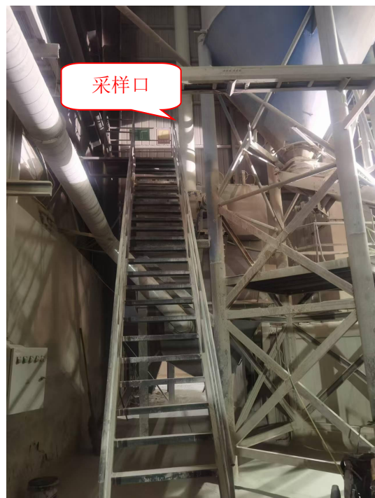
废气排放口（P2）采样口及采样平台
